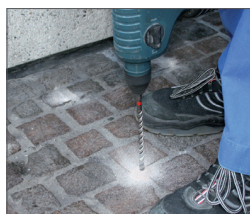
4 Percer dans la fondation
