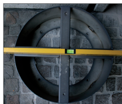
5 Déposer le socle sur les perforations
